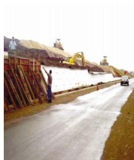
Obras de pavimento em Itanhaém, no litoral Sul de São Paulo
