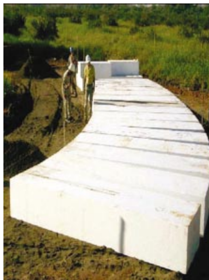
EPS inteiros com as juntas desencontradas
